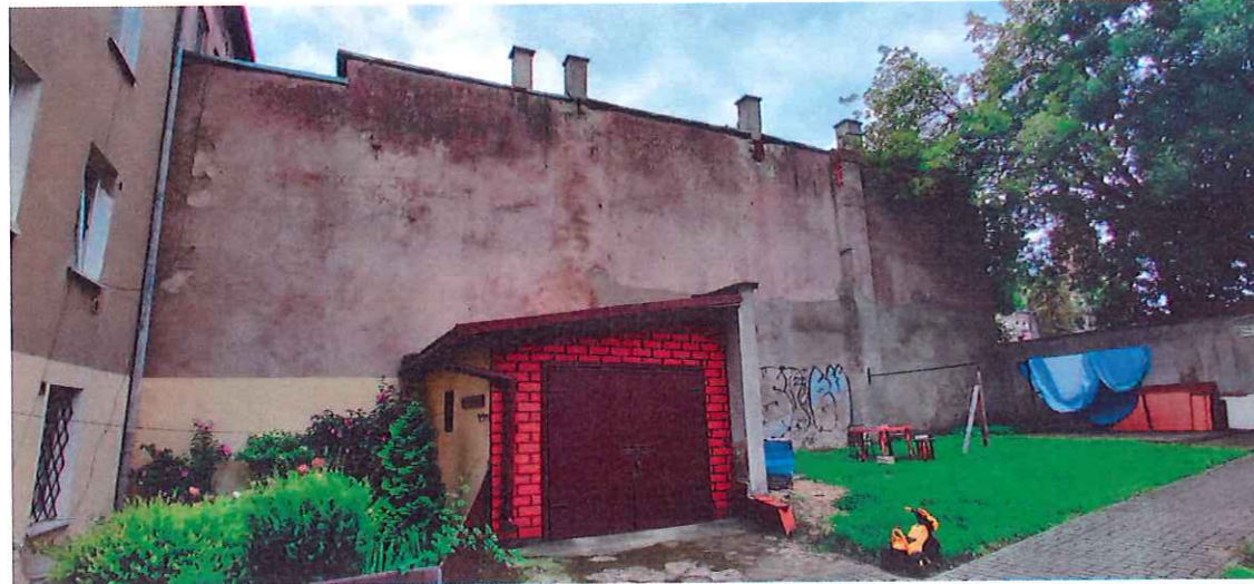
Fot. 3 Budynek oficyny - widok od strony północnej, z podwórka posesji Bardowskiego 22.
