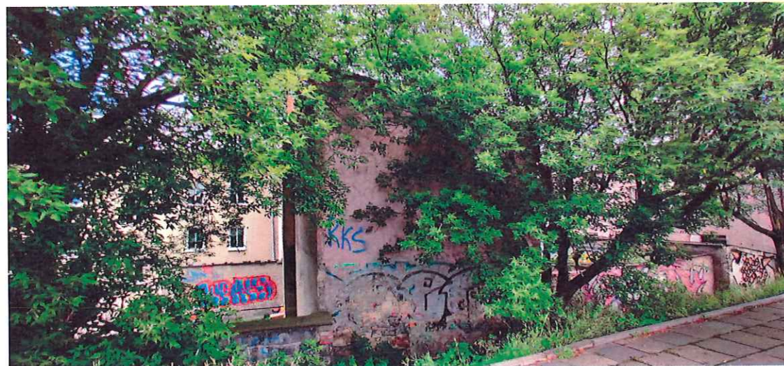
Fot. 6 Budynek oficyny - widok od strony zachodniej.
