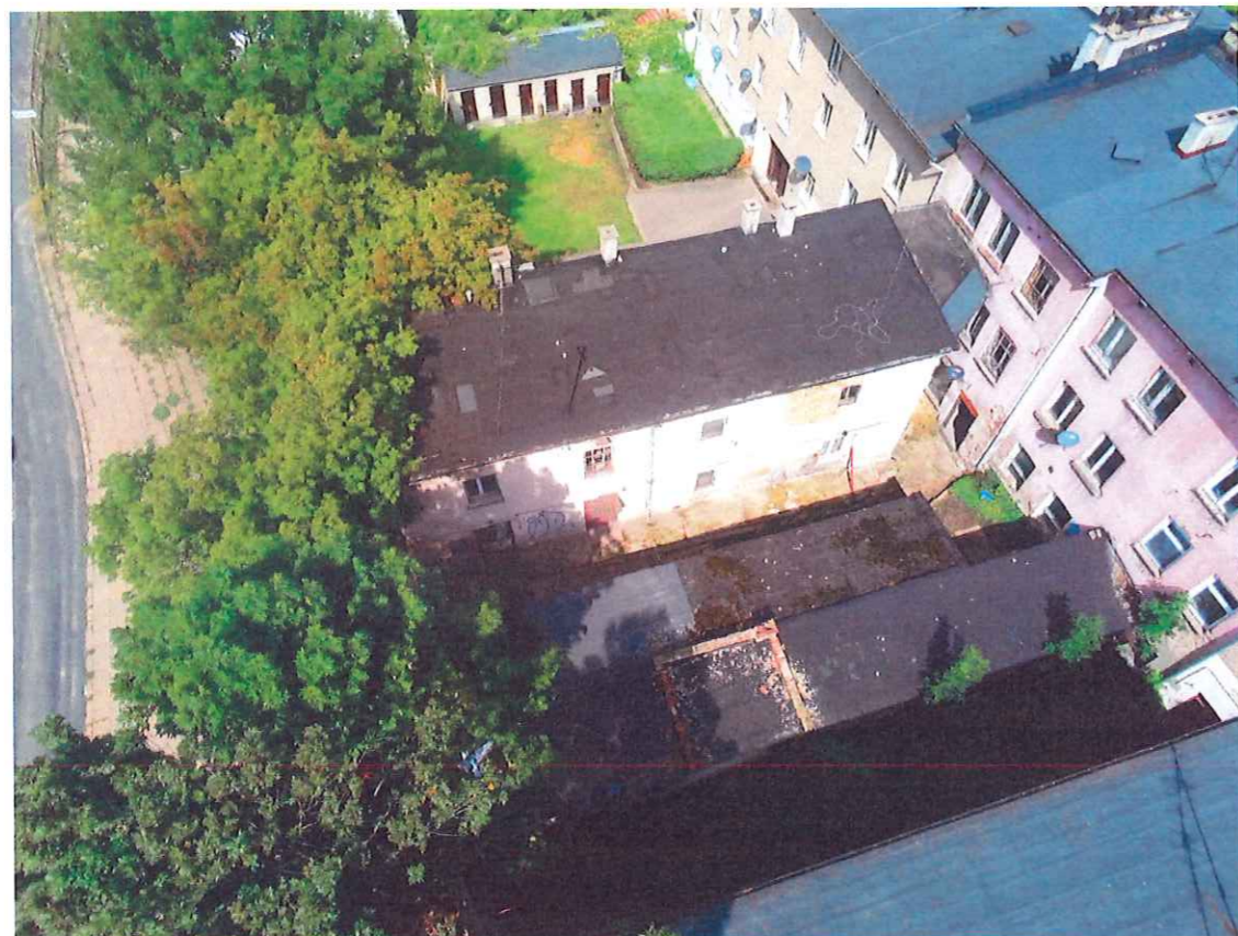
Fot. 1 Budynek oficyny - widok z lotu ptaka od strony południowej.
