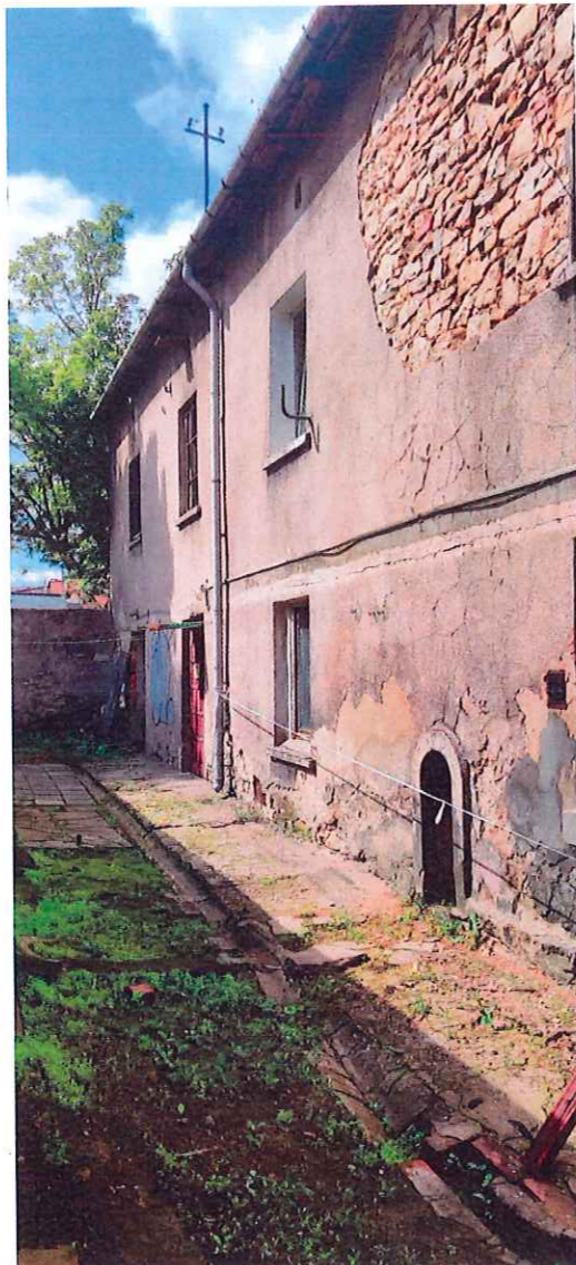
Fot. 4 Budynek oficyny - widok od strony południowo-wschodniej.
