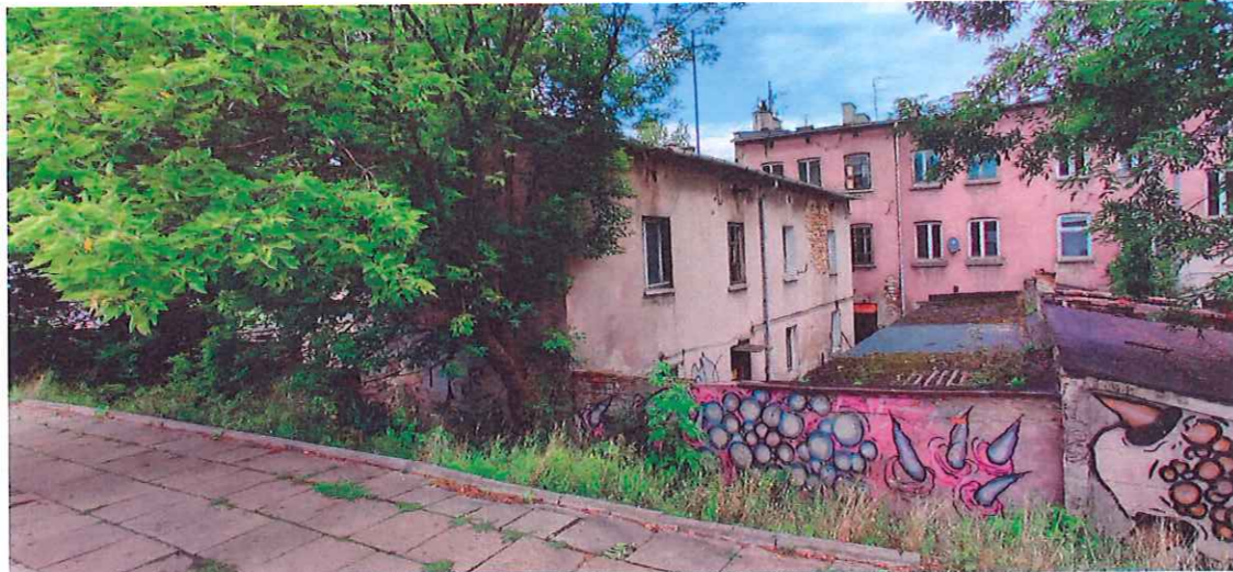
Fot. 5 Budynek oficyny - widok od strony południowo-zachodniej.
